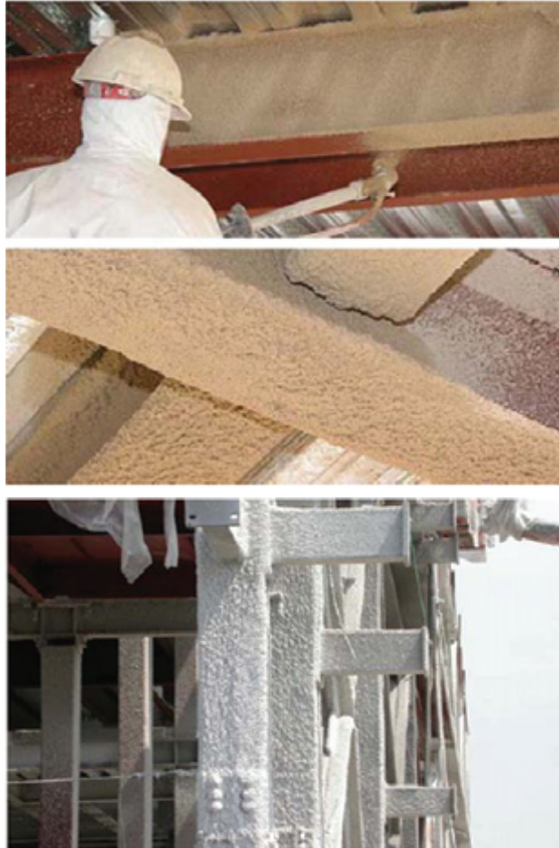
ภาพที่ ๔๕ การป้องกันโครงสร้างเหล็กโดยการพ่นด้วยวัสดุทนไฟ
