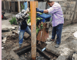
ดำเนินการดูดโคลนออกที่ท่อระบายน้ำและแก้ปัญหาน้ำที่อุดตัน
