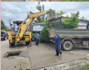
ดำเนินการซ่อมแซมและเปลี่ยนฝาท่อระบายน้ำที่ชำรุด
