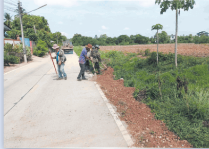
เทหินคลุก ซอยแม่สอด - อุ่มพาง
