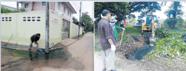
ดำเนินงานขุดลอกท่อระบายน้ำอุดตัน พร้อมขุดลอกเปิดทางน้ำ
