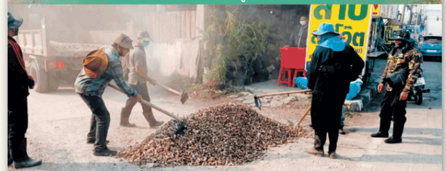
ลงหินคลุกบริเวณร้านลาบลุงไฉต
