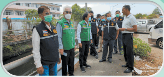
ลงพื้นที่ดำเนินการเปิดทางน้ำไหล สะพานหลังโรงเรียนเทศบาลวัดมณีไพโรสถมณี
