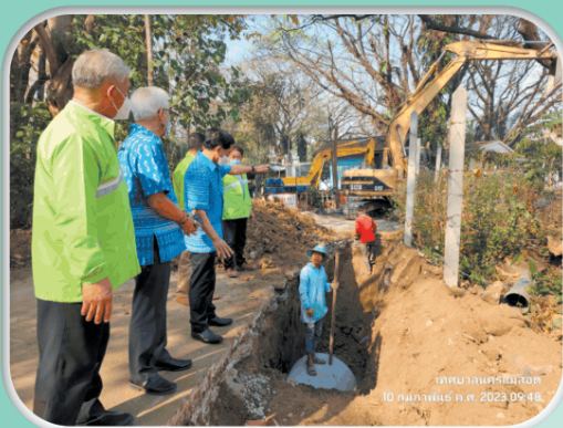
ลงพื้นที่ตรวจสอบความเรียบร้อย การวางท่อระบายน้ำ
